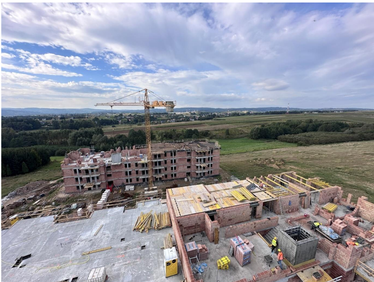
Prace budowlane na osiedlu SIM
