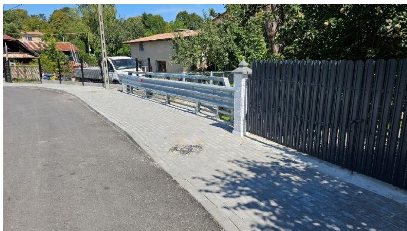
Przebudowa drogi 108192R w Lutoryżu
